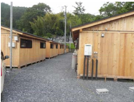
住田町の木造仮設住宅 の建設 2011.6.9
