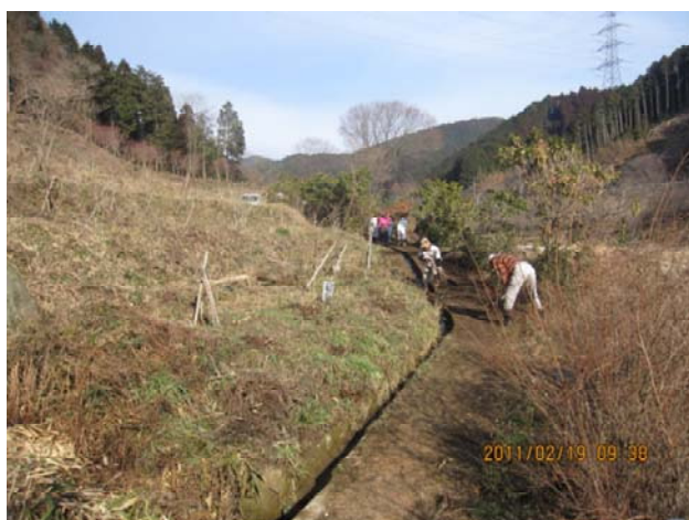
遊歩道の整備
