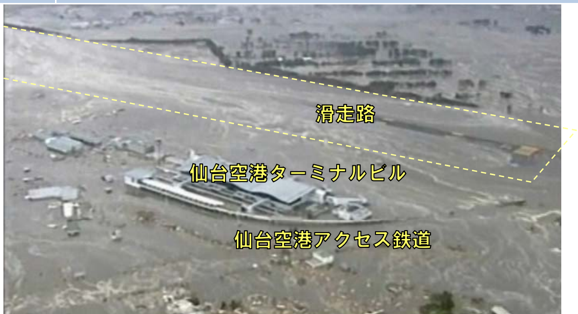
津波で冠水した仙台空港 (2011/03/11)
