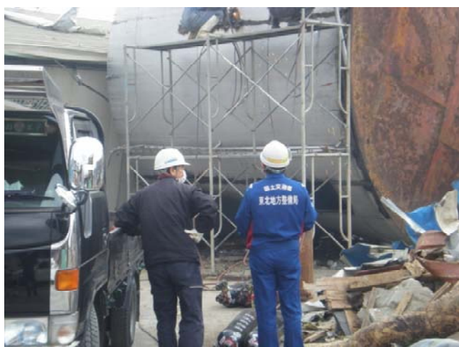
やまだまち 現場立会状況(岩手県山田町)
