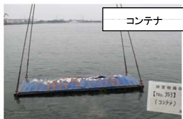
障害物の引き揚げ作業
