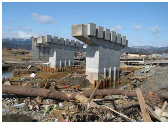
▲沼田跨線橋(上部工流出)
