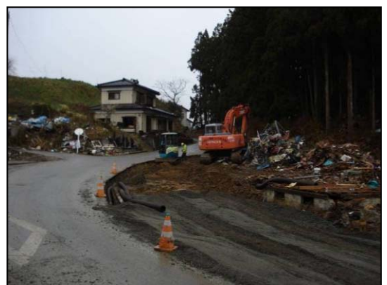
隘路箇所の拡幅工事状況
