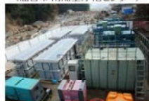
膜処理ユニットによる処理場と別位置での応急対応状況(陸前高田市)
