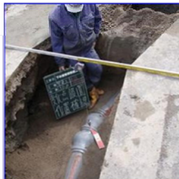
道路線形に合わせた施工(岡崎市)
