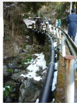
クイック配管(露出配管)(檜原村)
