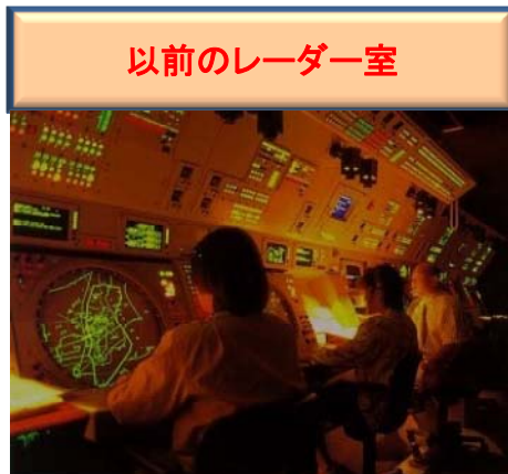
薄暗かったレーダー室は、平成16年から順次最新の管制機器に更新されており、表示装置が液晶となったため、室内の照度は一般的な執務室と同程度となった。
