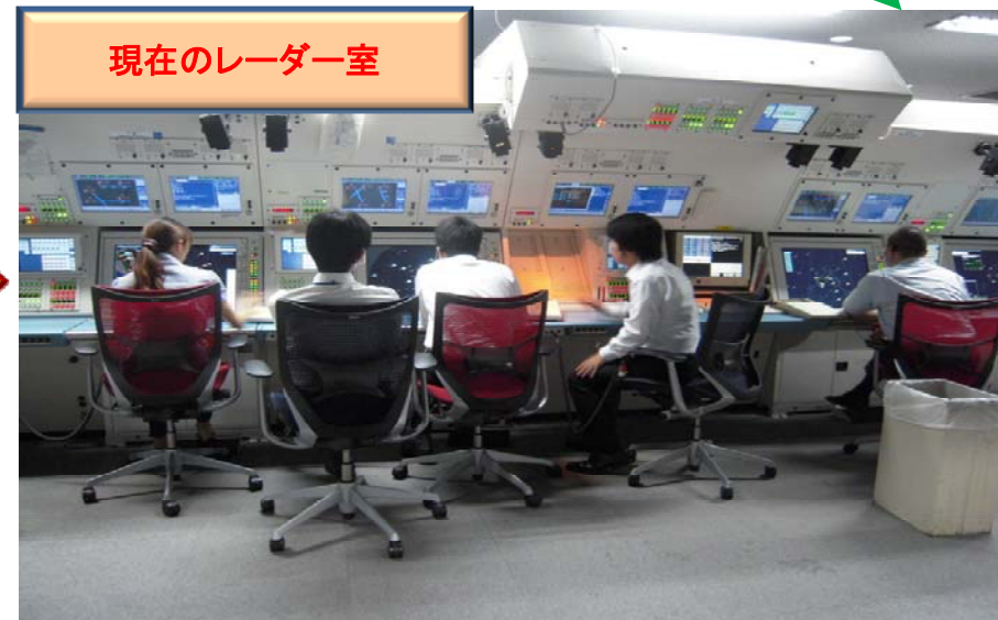
レーダー室内に窓はなく外部環境とは遮断されている
