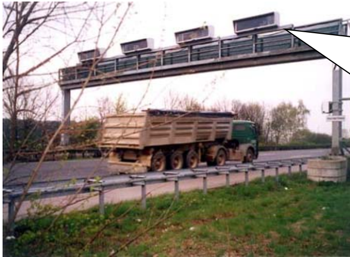
コントロールゲート
