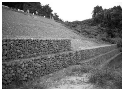
＜盛土のり尻補強＞
