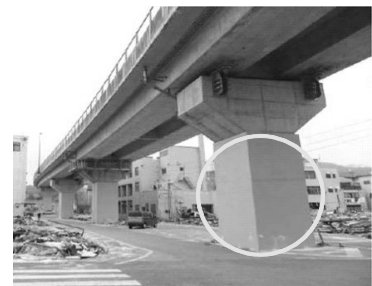
＜橋脚の耐震補強＞
