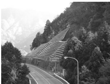
＜斜面崩落防止対策＞
