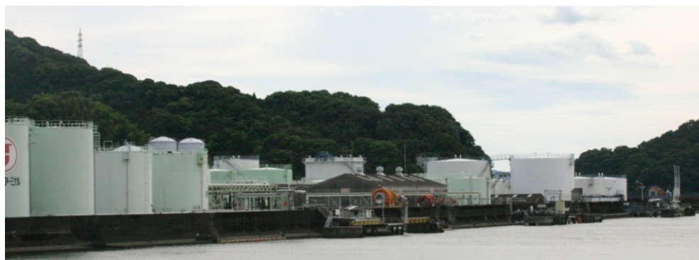
浸水区域内の石油備蓄基地
