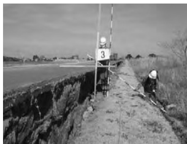
被災状況調査班(河川)
