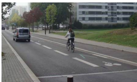
車道沿いに確保された自転車道
