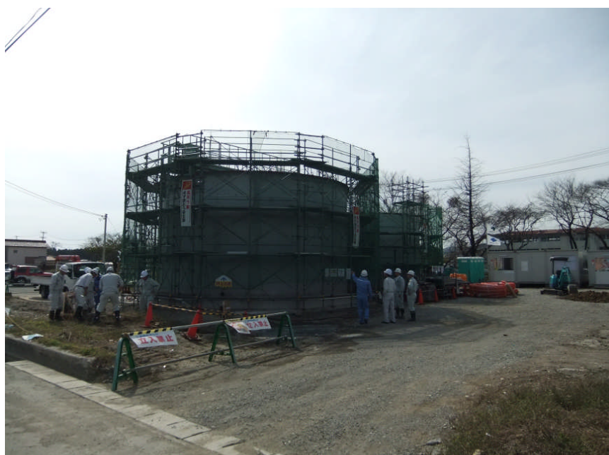
大川公園敷地応急仮設処理場
