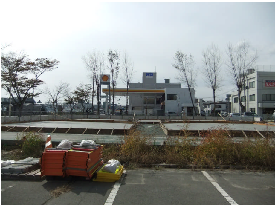
港町応急仮設処理施設施工状況
