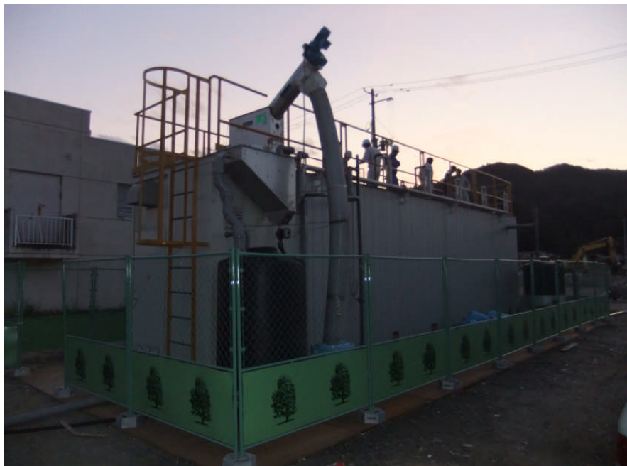
鹿折応急仮設処理場
