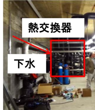
ポンプ場からバイパス管を通じて建物内の熱交換器で熱交換。
