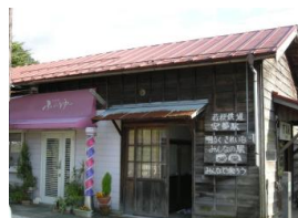
（安部駅の修繕）
