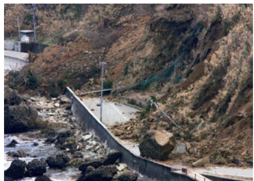
道路に巨石が崩落 輪島市門前町深見地区が孤立
