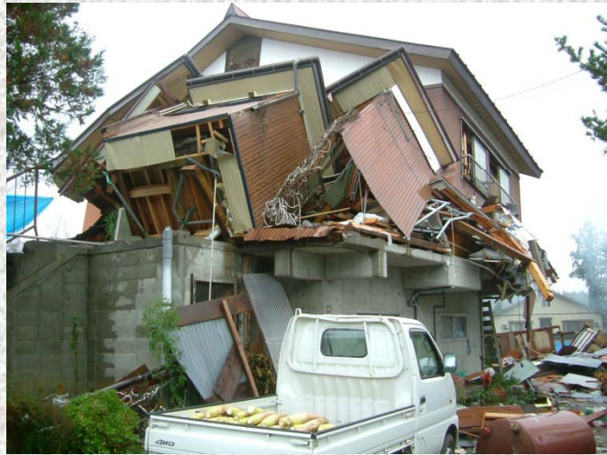
川口町の被災状況
