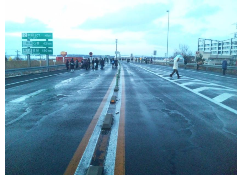
避難状況(仙台港北IC付近)
