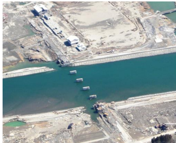
【道路の被災(気仙大橋)】
