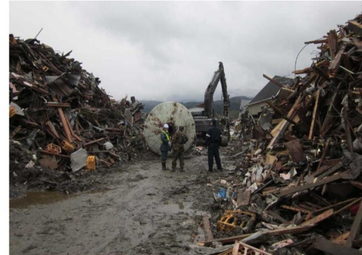
【道路の啓開(陸前高田市内)】
