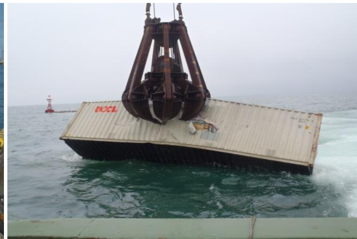
【航路の啓開(仙台塩釜港)】
