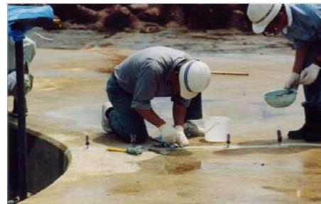
クラックの補修状況(注入工)
