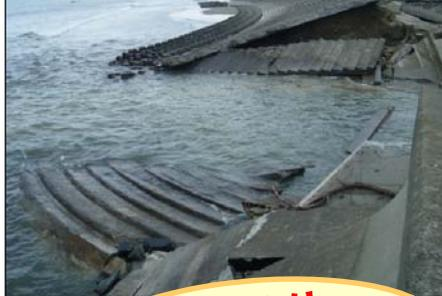
岩手県、宮城県、福島県では、約300km存在した海岸堤防・護岸のうち約190kmが全半壊(3県合計)
