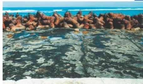
護岸コンクリート部の劣化
