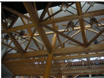
市民ホール吹抜け天井
