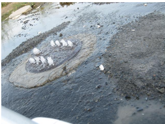
写-4.1 石巻市内の人孔からの溢水
