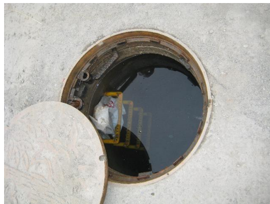
写-4.2 大槌町内の人孔滞水
