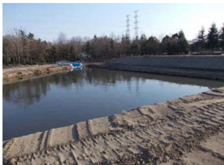
緩衝緑地仮沈殿池(3/21~4/19)
