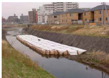
要害川仮沈殿池(未使用)
