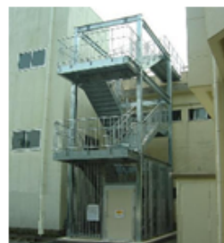
改修事例(外階段の設置)
