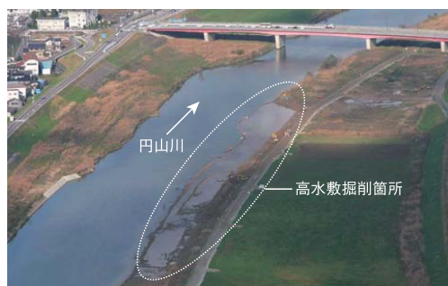
治水効果だけでなく、魚類の生息やコウノトリの採餌場としての機能を持つ湿地の再生も目指し高水敷掘削の形状を工夫した。
