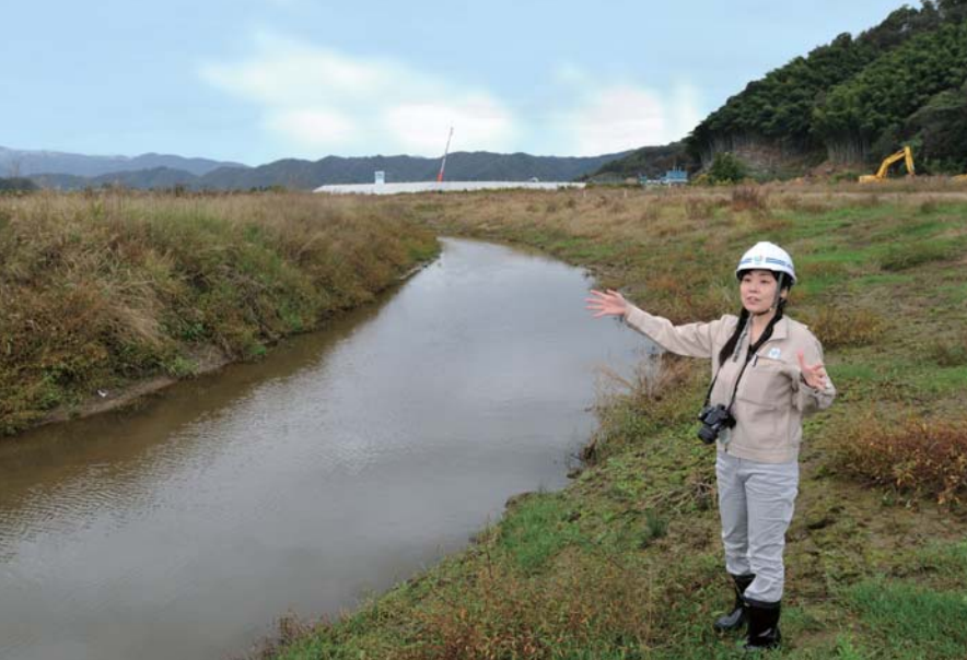
加陽地区では湿地を整備する途中段階で、生物だけでなく水路の形状や流れの変化、出石川の様子なども調査する。この調査結果は次の工事へ反映させる。
