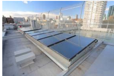
太陽熱利用温水システムとバックアップガス給湯器
