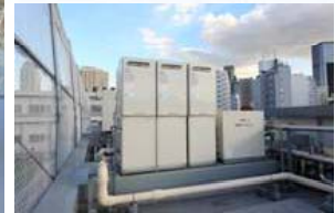
太陽熱利用温水システムとバックアップガス給湯器
