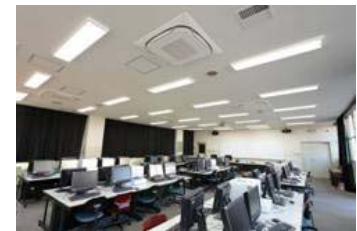
ガスヒートポンプ冷暖房システム(室外機と室内機)
