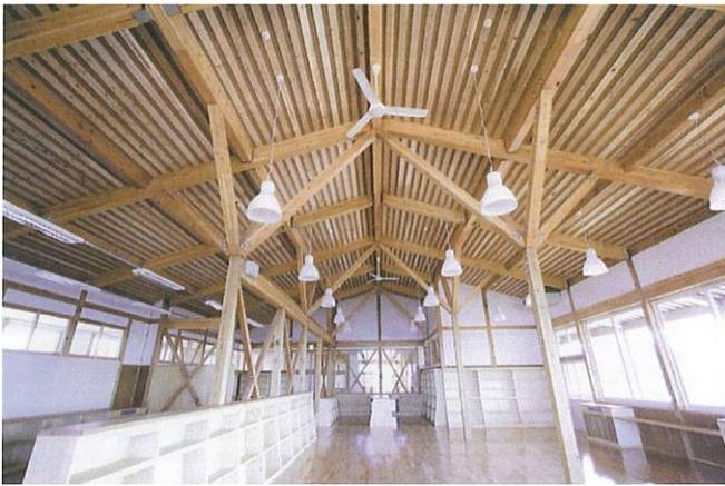
図書室コンピューター室 天井：秋田杉樹皮ボード吸音断熱
