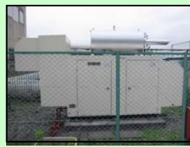
自家発電設備
