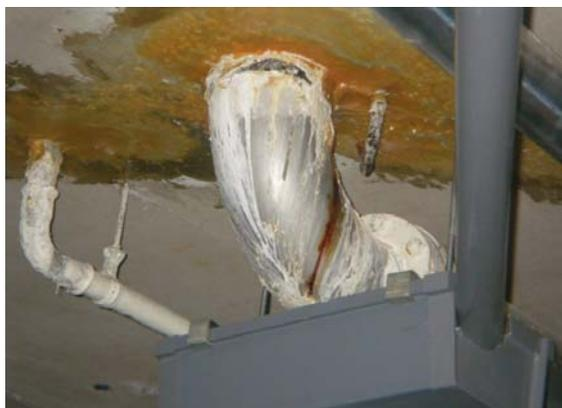
〔漏水が発生しており、排水設備の改修が必要〕
