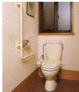
手すりの設置
