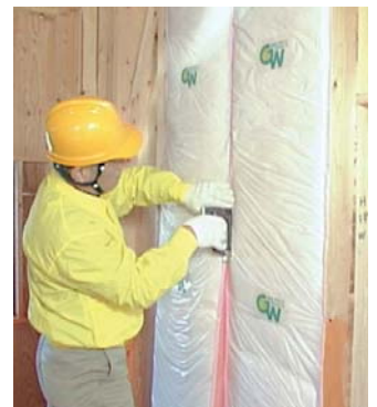
壁の断熱工事
