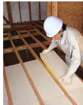
床の断熱工事
