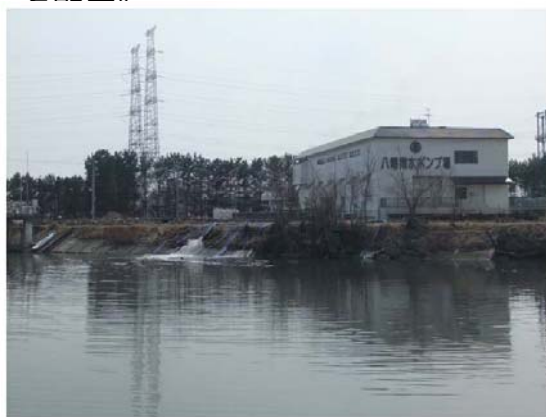
仮設ポンプによる排水
