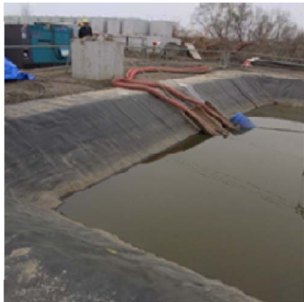
汚水ポンプ場（停止中）付近で簡易沈殿処理、消毒後、本川まで導水して放流（旧北上川（石巻市内））
