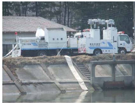
移動ポンプ車による排水
