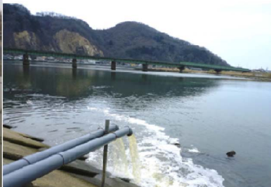
汚水ポンプ場（停止中）付近で簡易沈殿処理、消毒後、本川まで導水して放流（旧北上川（石巻市内））
