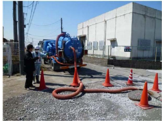
バキュームカーによる吸引状況（潮来市）
