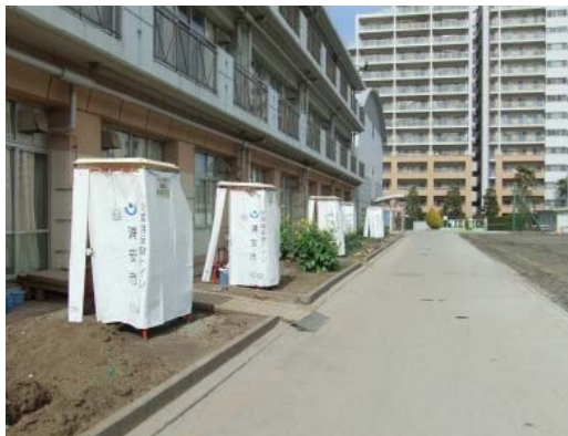
災害用トイレの設置状況
