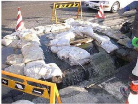
土のうを用いて近傍の側溝への消毒放流状況その1 (多賀城市)
