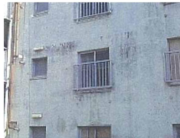
【写真】 築55年(計画修繕が行われていない物件) 経年によりコンクリートが剥離し、外壁面の鉄筋が露出している例
