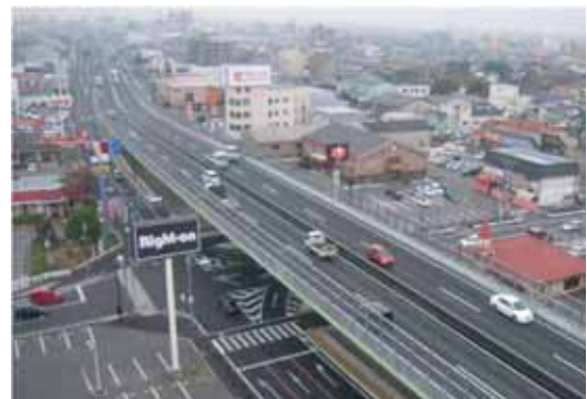
<大気質対策（交差点立体化 [国道2号]）>
