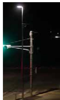
< LED道路照明灯 >
