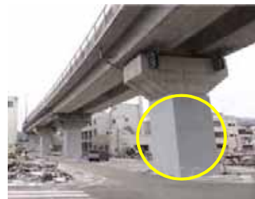
< 橋脚の耐震補強 >
