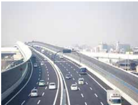
<騒音対策（遮音壁 [第二京阪道路]）>
