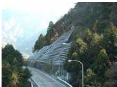
< 斜面崩落防止対策 >
