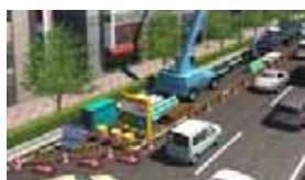
夏にガス工事
