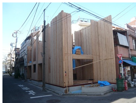
本工法を使用した物件の施工 (2010年11月～3月東京都内) 交付金対象外
