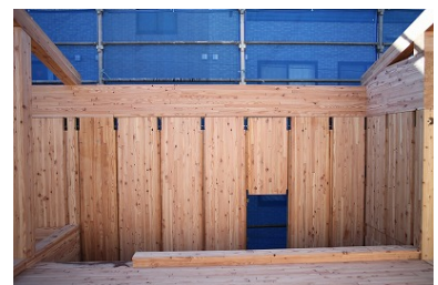
頭つなぎ材・壁パネル接合部
