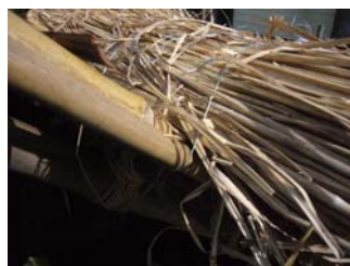
茅を屋根下地の竹に固定 針金で縫うように縛り付け、この作業には2人(針受けと針返し)必要
