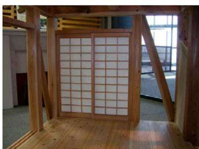
内部建具として製作した障子
