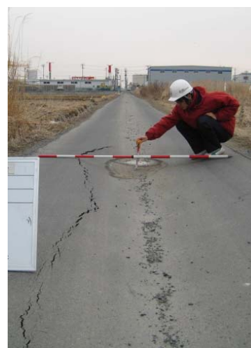
写真-3 液状化対策施工（被害有り）
