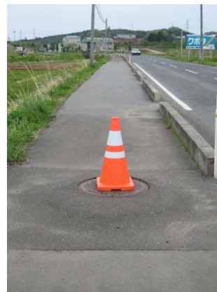
写真-5 液状化対策施工箇所（被災箇所）
