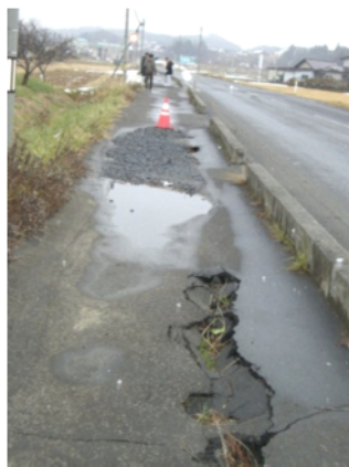
写真-4 標準施工（未対策）
