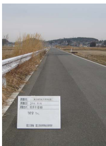
写真-2 液状化対策施工（被害なし）
