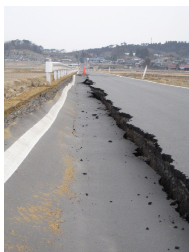
写真-1 標準施工（未対策）
