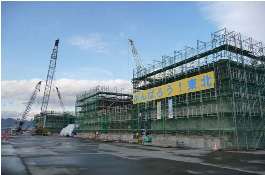
宮古港 ケーンヤード
