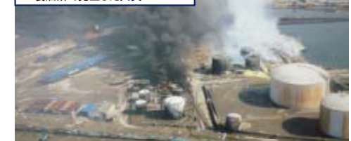
東日本大震災において仙台製油所で発生した火災
