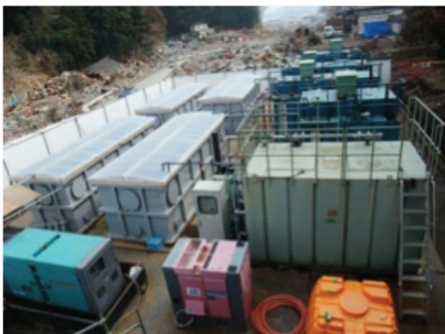
膜処理ユニットによる応急対応（岩手県陸前高田市）
