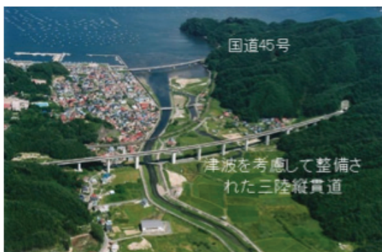
津波を考慮して整備された三陸縦貫道
