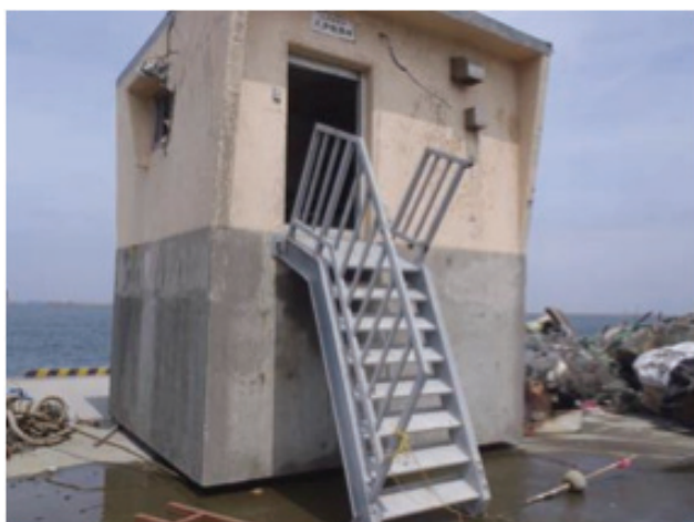
流失し、後日引き揚げられた八戸検潮所
