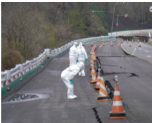
国道 6 号富岡町上郡山 調査状況
