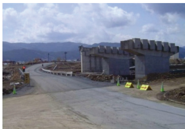
復旧作業後 (3 月 25 日交通開放)
