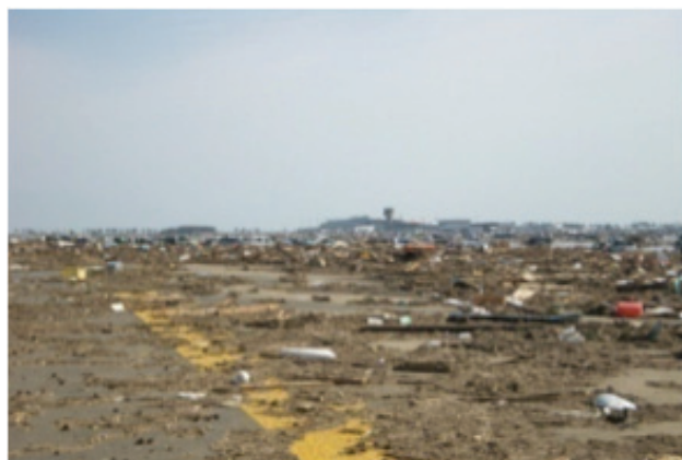
仙台空港B滑走路被災状況
