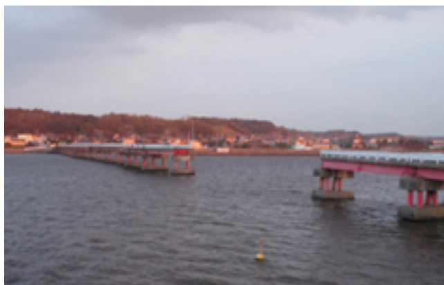
国道354号(茨城県管理)鹿行大橋
