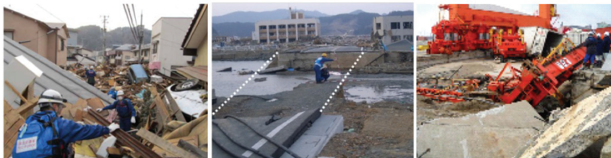
河川、道路及び港湾における被害状況調査
