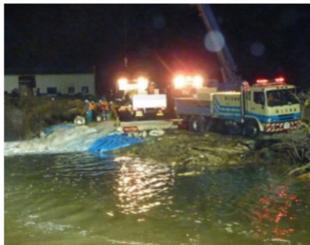
排水作業状況 (石巻市大川地区)
