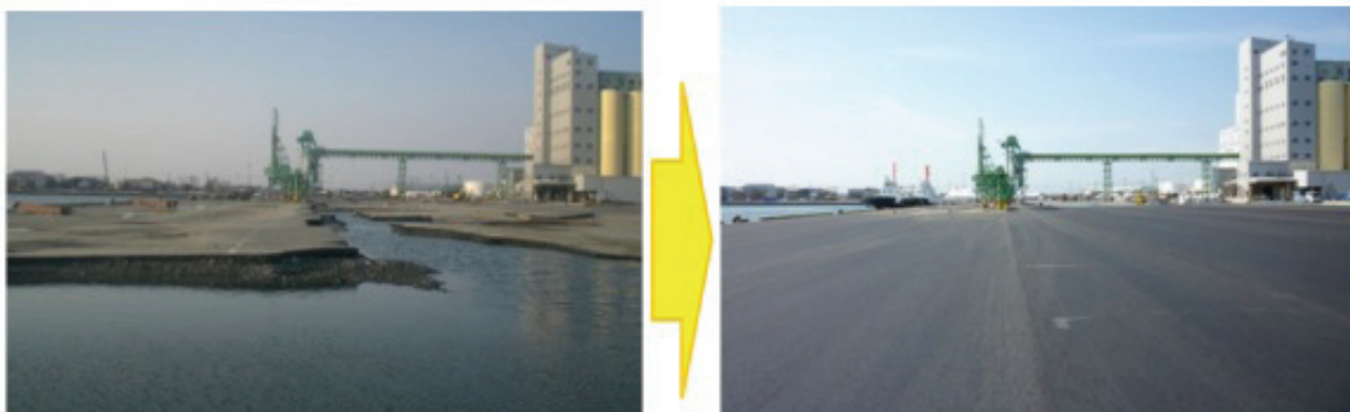
石巻港岸壁（-10m）の応急復旧の状況
