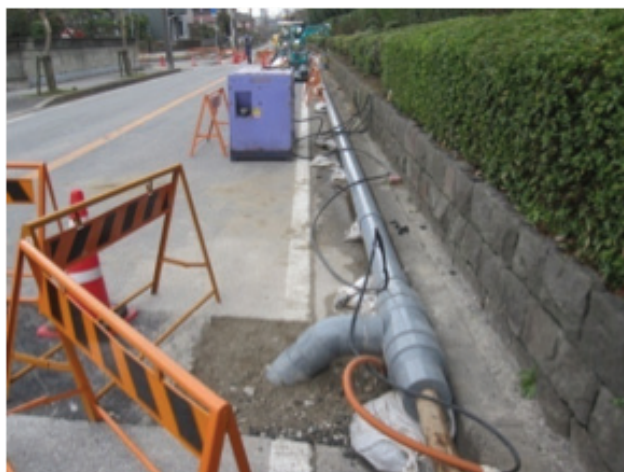
仮設配管（千葉県習志野市）
