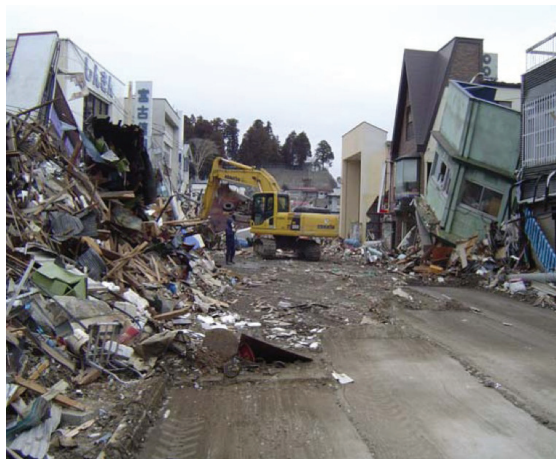
啓開作業中（岩手県山田町内）
