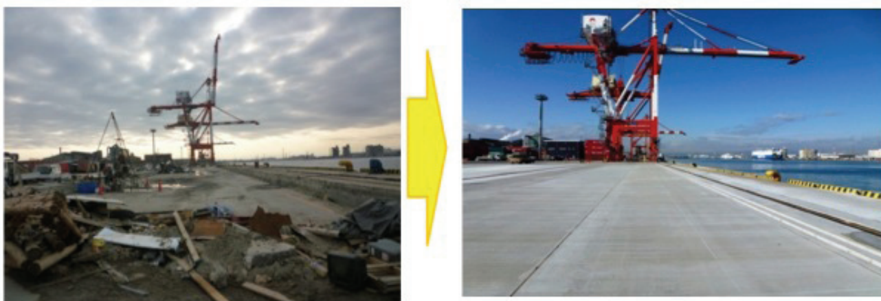
仙台塩釜港（仙台港区）岸壁（-14m）の応急復旧の状況
