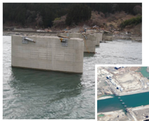
国道45号気仙大橋
