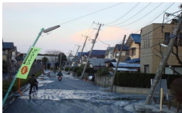
傾いた電柱（千葉県習志野市）
