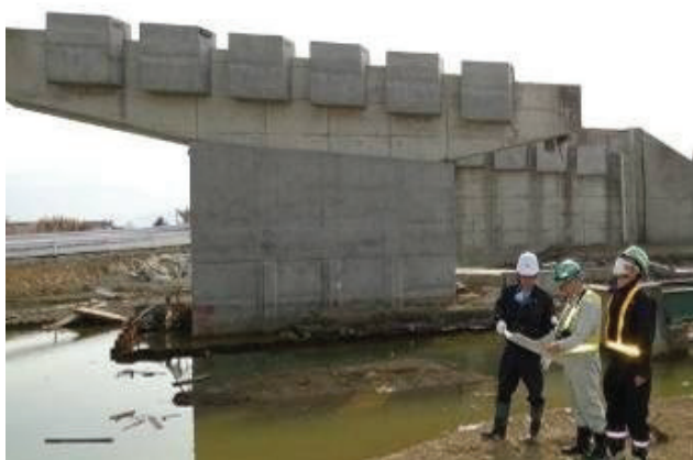
津波により被災した道路橋の調査、技術的助言
