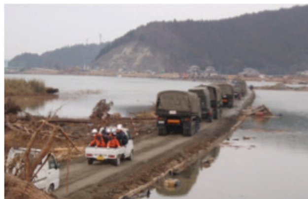
工事用道路1車線復旧完了
