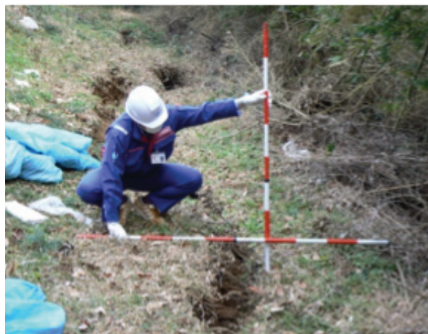
土砂災害危険箇所点検実施状況(茨城県鉦田市)
