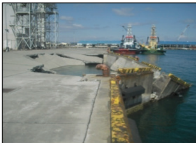
相馬港岸壁（-7.5m）の被災状況
