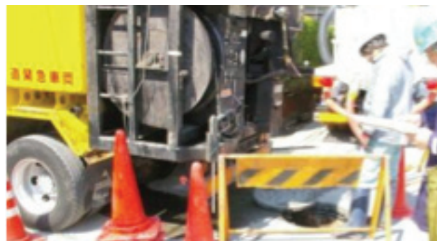
管路の被害状況の調査、清掃作業を行う職員
