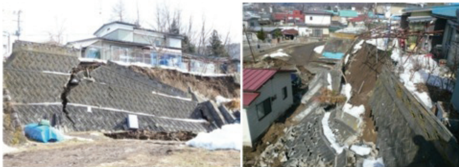
二戸市被災宅地状況調査
