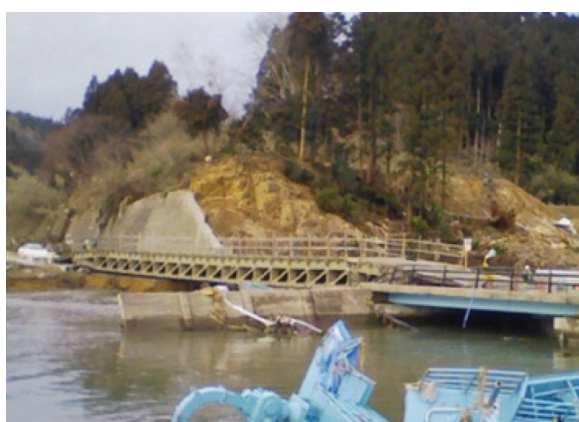
組立式橋梁設置後 (3 月 19 日片側交互通行開放)
