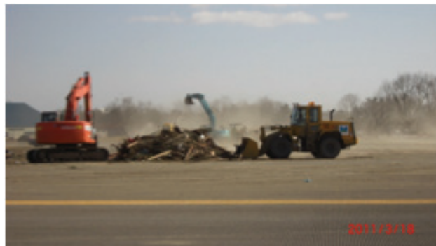
ガレキ処理作業中
