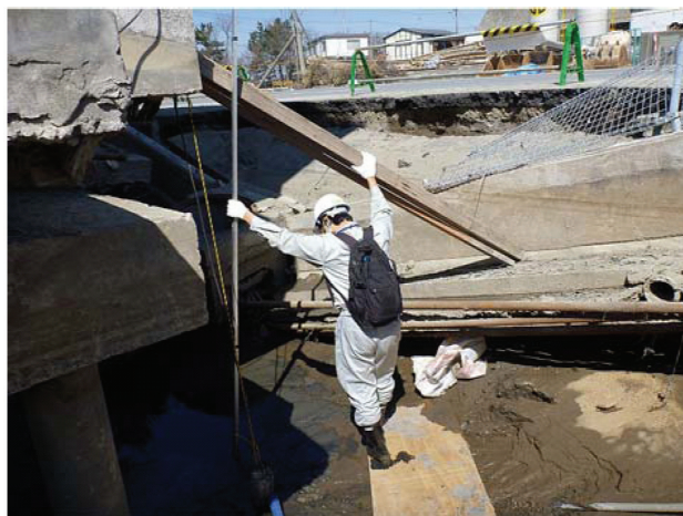
浸水した庁舎の被災状況調査（宮城県石巻市）
