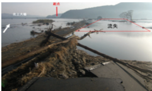
北上川堤防被災（宮城県石巻市）
