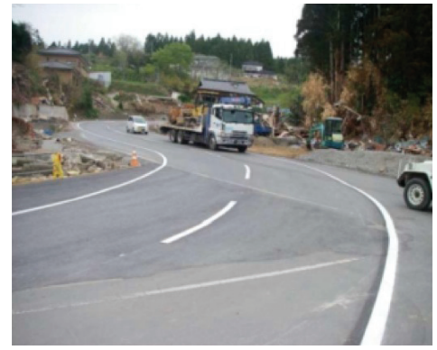
迂回路拡幅完成 (5月11日)
