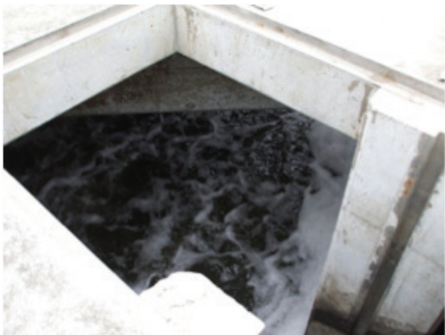
通常処理まで復旧し、曝気をしている様子（福島県新地町）
