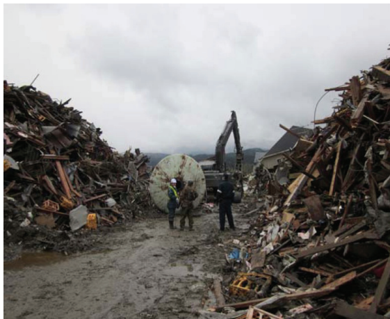
啓開作業中（岩手県陸前高田市内）
