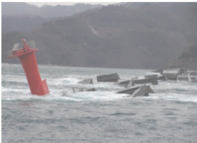
釜石港湾口防波堤の被災状況
