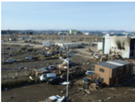
仙台空港復旧前
