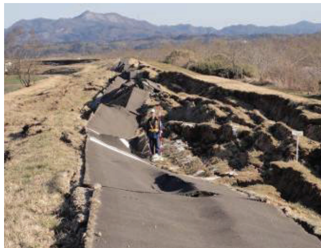
液状化により被災した河川堤防の復旧方法に関する技術的助言
