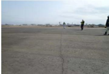
液状化による舗装の沈下
