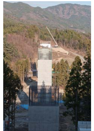
大船渡市に建設中の吉浜高架橋。三陸沿岸道路を形成する道路。
