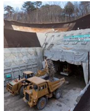
田野畑村の尾肝要（おかんよう）トンネル工事現場。この付近は三陸沿岸道路の予定ルートの中でも特に起伏に富んでいるため、開通後は大幅な時間短縮になる。平成24年度中の完成を目指して24時間体制で工事中。
