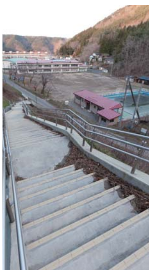
岩泉町小本地区にある避難階段。小本小学校の生徒は高さ12mの防潮堤を越えて川を遡ってくる津波からこの階段で学校の背後にある国道45号へ避難し難を免れた。階段は町長からの要請で平成21年3月に三陸国道事務所が整備した。
