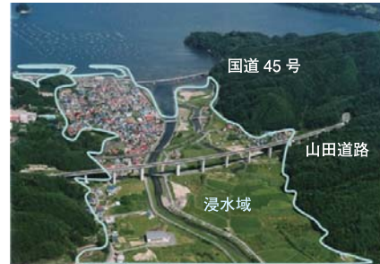
三陸沿岸道路（山田道路）
