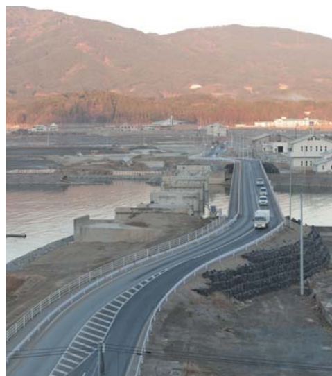
約180mあった元の気仙大橋は、左側の橋脚だけ残っている所にあった。緊急に仮橋を架ける応急復旧工事を行い、予定より2カ月以上早い7月10日に仮橋が開通した。
