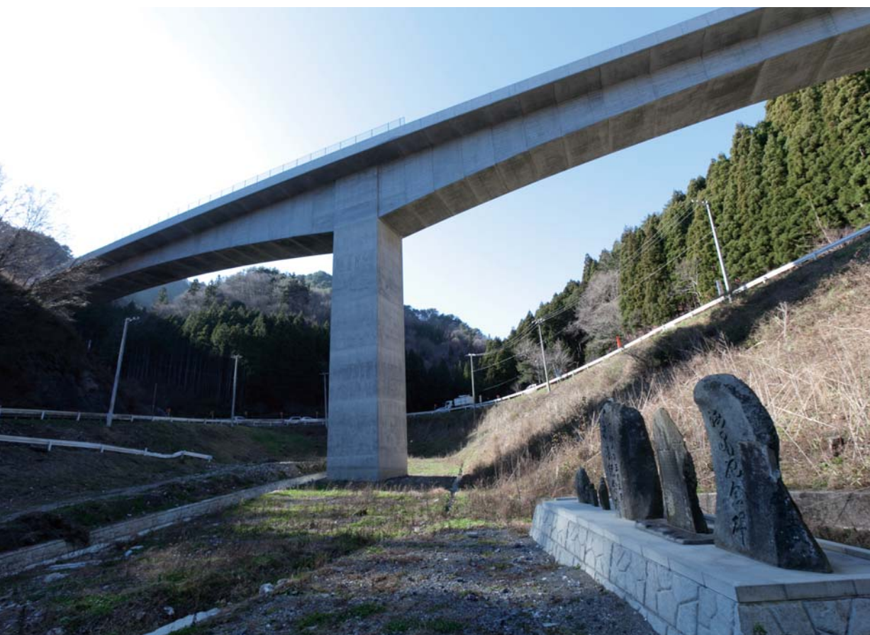
釜石市両石町にある、明治と昭和の大津波記念碑。犠牲者への慰霊と後世への警鐘として津波到達地点に点在していた碑を合祀。東日本大震災の津波はそれを越えた。中央は国道45号、その上の高架は三陸沿岸道路の一部である釜石山田道路。
