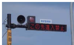
津波浸水想定区域には、以前から津波標識を設置していた。昨年2月、先行的に宮古市で「津波警報板」を設置し始めたその約2週間後に地震が発生。「津波警報」が発令された時に、通行中のドライバーや歩行者にその情報を即時に提供し、自主的な避難を促すことが重要。津波警報板の整備を進めています（波邊）
