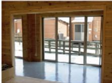
サンルーム側の床をコンクリートで作ることにより、冬の日射を受け、蓄熱する。また、床蓄熱を含めサンルーム全体の空気を太陽熱を用いて暖め、冬の暖房に用いる。
