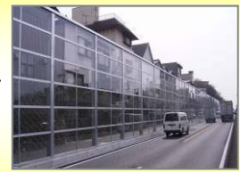
設置後:63dB(夜間)
