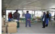
朝8時からの朝礼に参加して、その日の作業内容等を確認
