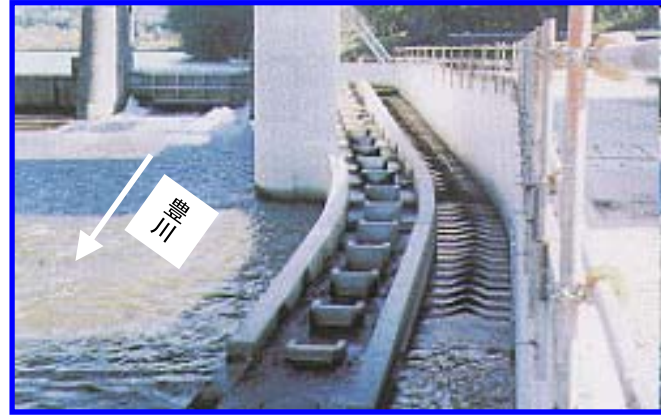
牟呂松原頭首工の魚道 (H8年度完成)
