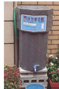
・雨水貯留槽
