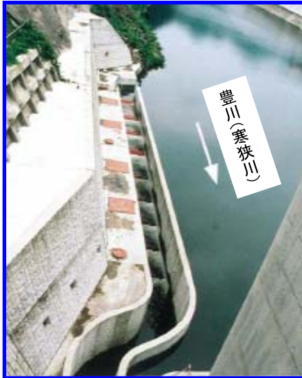
寒狭川頭首工の魚道 (H8年度完成)
