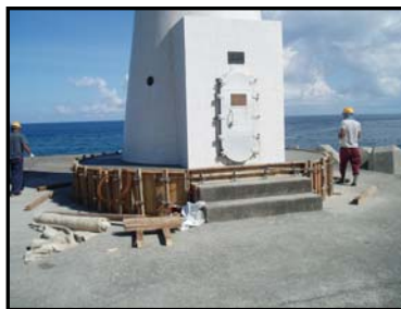
▲航路標識の基礎を補強▲
