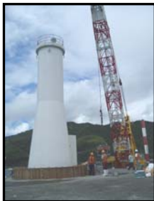
▲航路標識の基礎を補強▲
