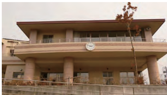
写真10 1階が津波により被害
