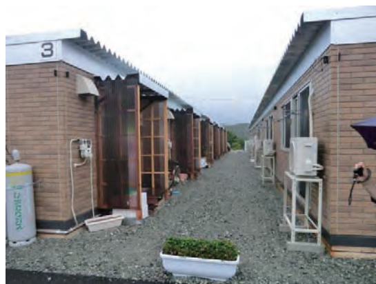
写真8 応急仮設住宅外観
