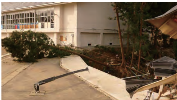
写真11 体育館の被害
