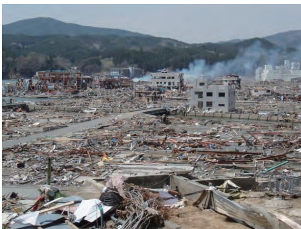
写真1 南三陸町（志津川）の被害
