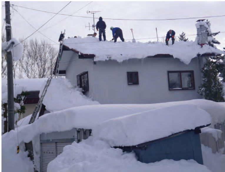
写真1 雪下ろし作業の状況
