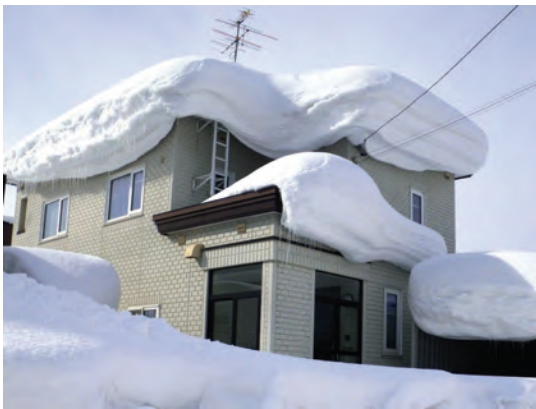
写真 2 雪庇の発生とはしごの埋没
