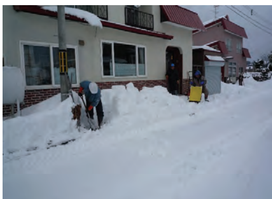
写真7 雪の塊を除去している状況
