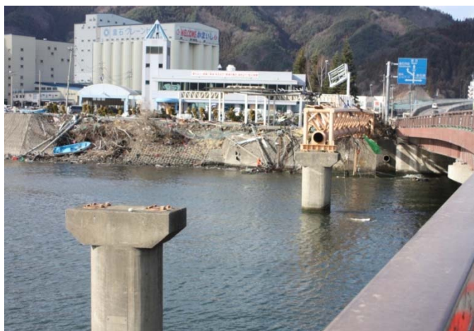
落下した水管橋 平成23年3月28日
