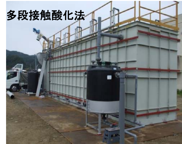
<仮設処理施設①>
