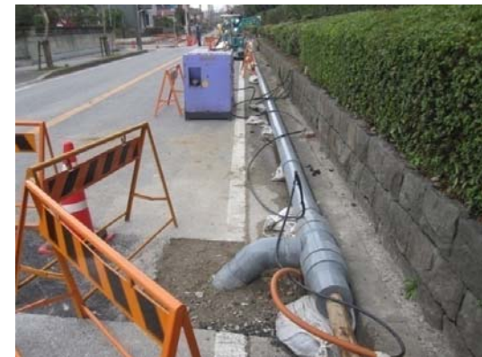
仮設配管による応急復旧 (千葉県 習志野市)
