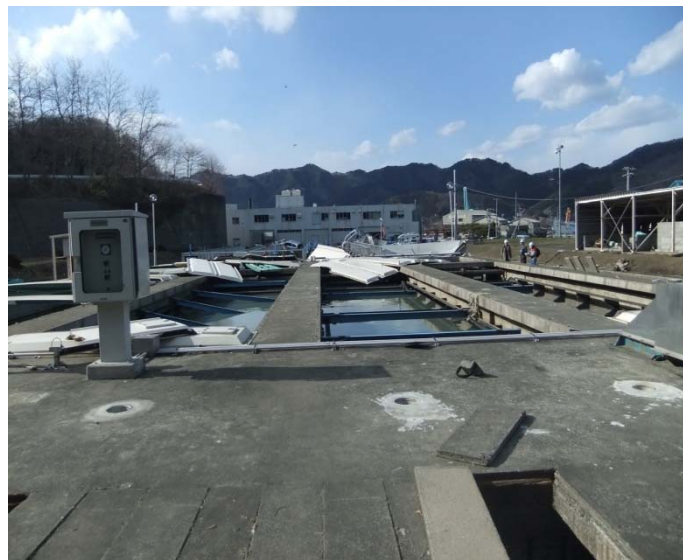
水処理上部 蓋等が流失
