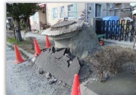
液状化により隆起したマンホール (千葉県浦安市)
