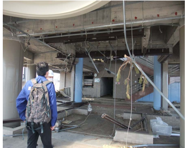
管理等入り口付近は津波により破壊
