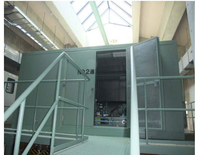
2階上部にあった脱水機は 浸水を免れた
