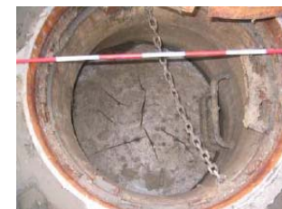
マンホールの閉塞
