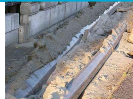
下水管の浮上
