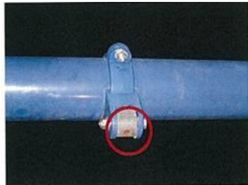
吊金具の破損
