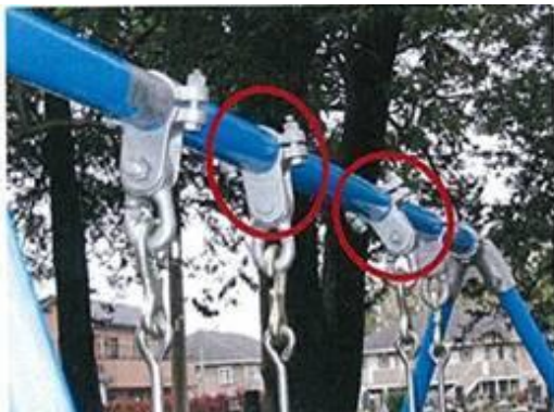
吊金具のずれ
