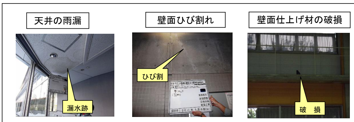
写真-10 建築物内部の異常の判定例
