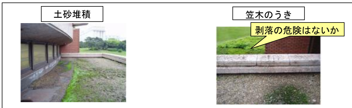
写真－9 建築物屋根の異常の判定例
