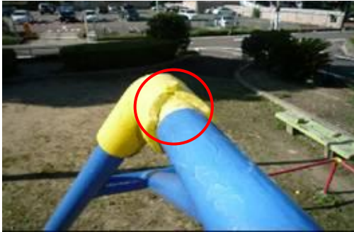
継ぎ手金具の破損
