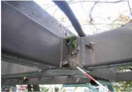
支柱部の腐食
