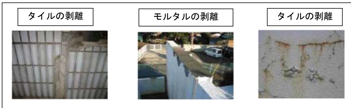
写真－8 建築物外部の異常の判定例
