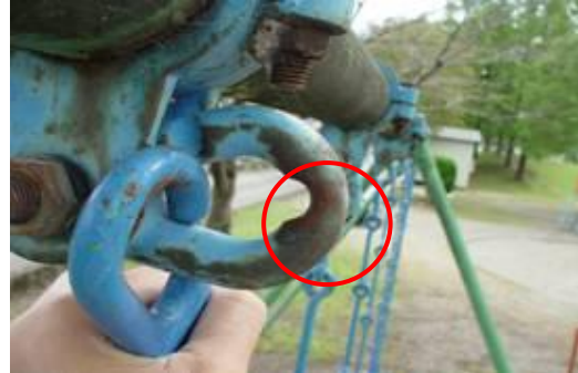
吊金具の摩耗
