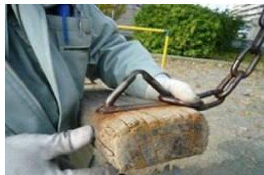
金具摩耗と座板の腐朽
