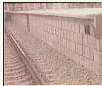
盛土式ホーム
