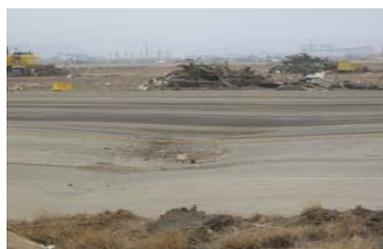
液状化による舗装の沈下
